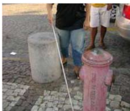
Foto 10, 11 e 12 – Borda de espelho d'água, hidrante e luminária sem piso tátil de alerta (situações de perigo).
