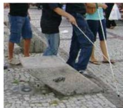
Foto 10, 11 e 12 – Borda de espelho d'água, hidrante e luminária sem piso tátil de alerta (situações de perigo).
