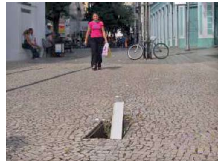
Foto 01 – Caixa de inspeção (tampa retirada)
