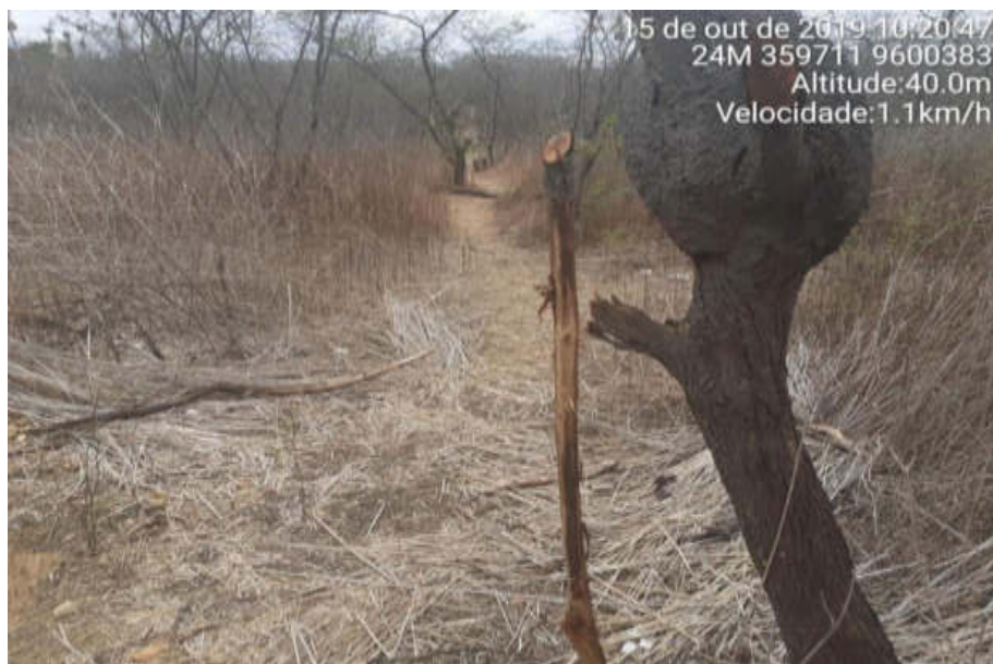
Picada aberta para demarcação da faixa de Acesso ao Novo Aeroporto de SObral/CE.
