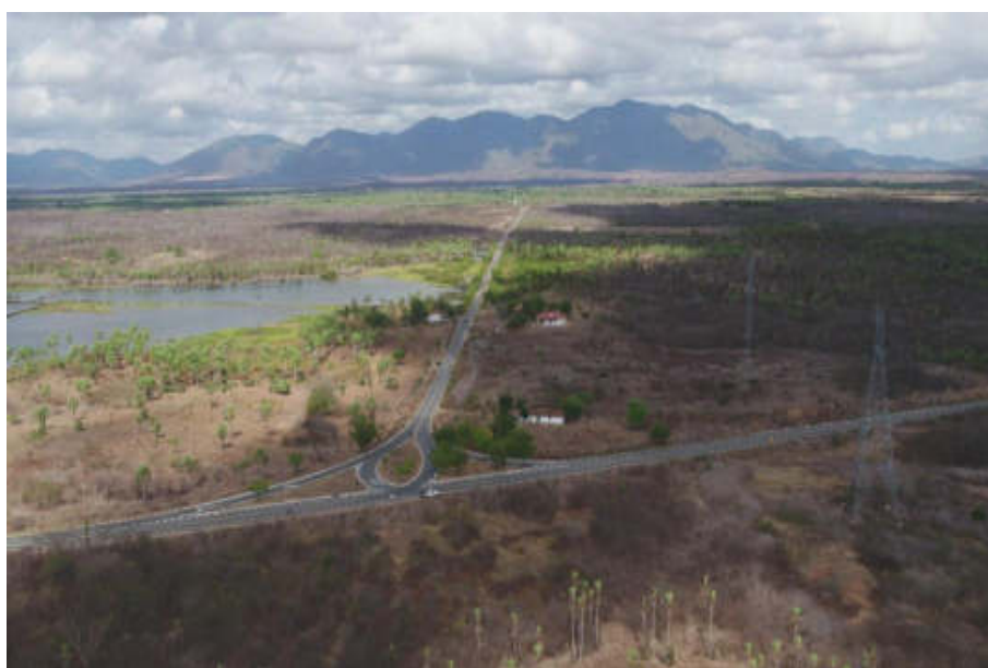
Imagem aérea do entroncamento de acesso ao Novo Aeroporto de Sobral/CE.
