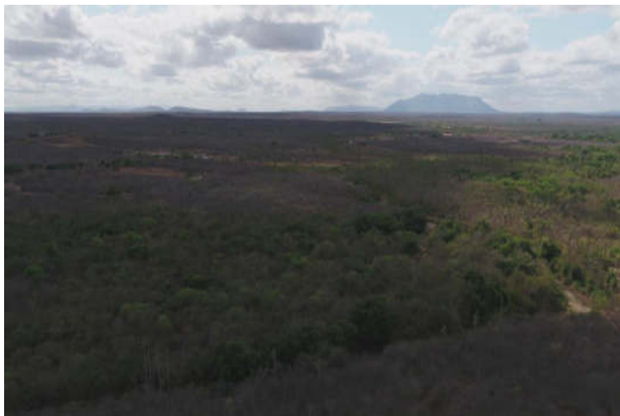
Imagem aérea do local de Implantação do Novo Aeroporto de Sobral/CE.
